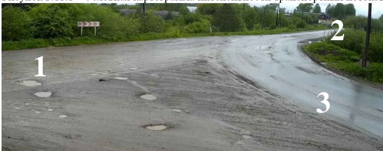
Рисунок Г.11.2 – Фото перекрестка ул. Свердлова – ул. Промышленная, г. Кудымкар
