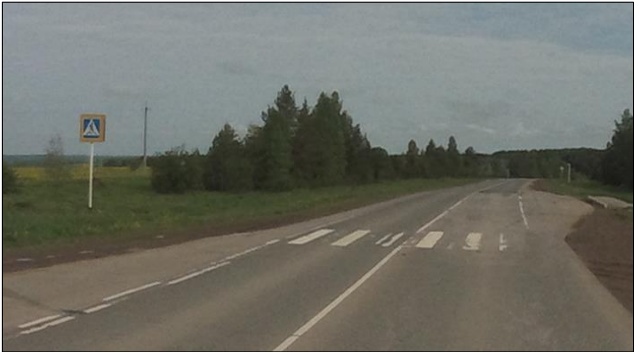
Рисунок 1.7.5 – Пример эксплуатационного состояния горизонтальной разметки 1.1 (разделяющей транспортные потоки противоположных направлений) и разметки 1.14.1 (обозначающей пешеходный переход) нанесённых на 9 км а/д 57 ОП РЗ 57К-0073 «Кудымкар-Гайны»
