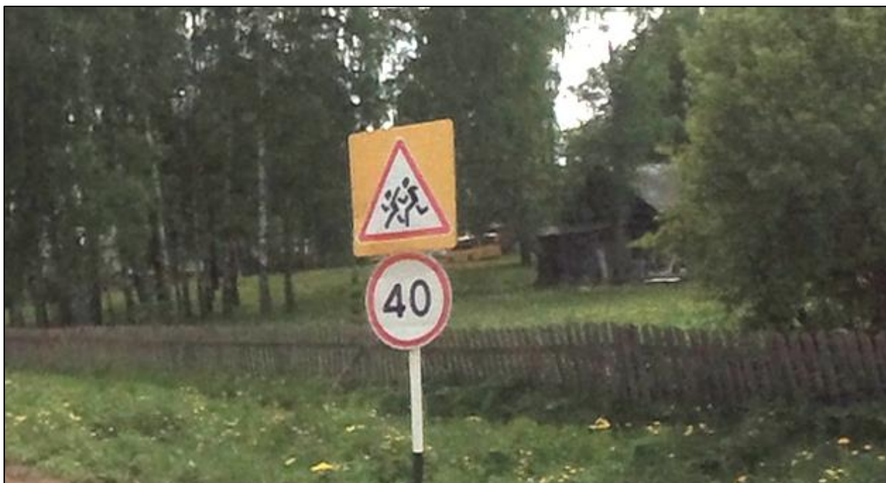
Рисунок 1.7.3 – Вид эксплуатационного состояния знака 1.23 «Дети» на желтом фоне и знака 3.24 «Ограничение максимальной скорости» расположенных по ул. Центральная в д. Гурина
