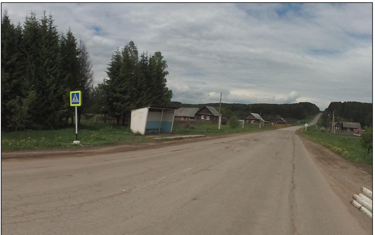
Рисунок 1.7.6 – Пример неудовлетворительного состояния разметки 1.1 и отсутствия разметки 1.14.1 на а/д Кудымкар – с. Ошиб (д. Зюльганова)
