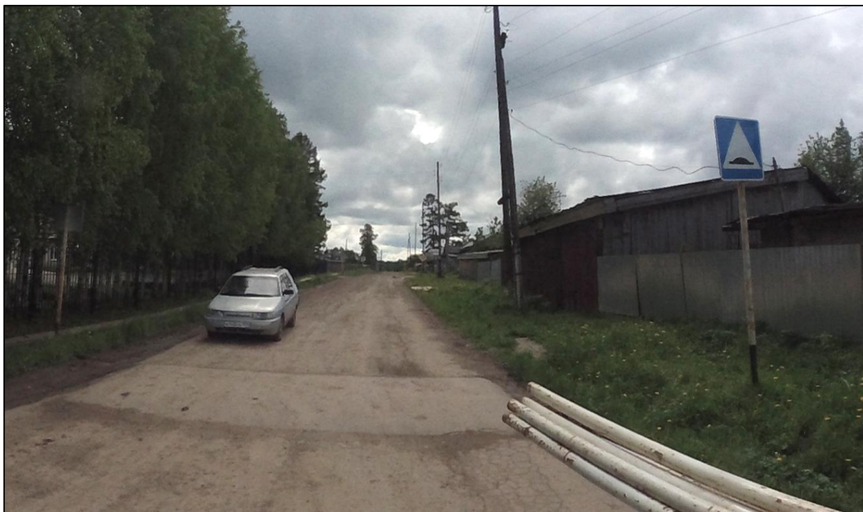
Рисунок 1.7.7 – Пример эксплуатационного состояния ИН неровности монолитной конструкции, расположенных по ул. Октября, с. Кува
